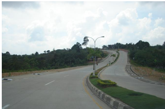
Jalan Trans Kalimantan yang menghubungkan antara Kecamatan Tenggarong Seberang dengan Kecamatan Tenggarong
