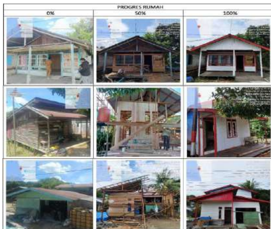
Rehabilitasi Rumah Tidak Layak Huni di Desa Loa Raya Kec. Tenggarong Seberang
