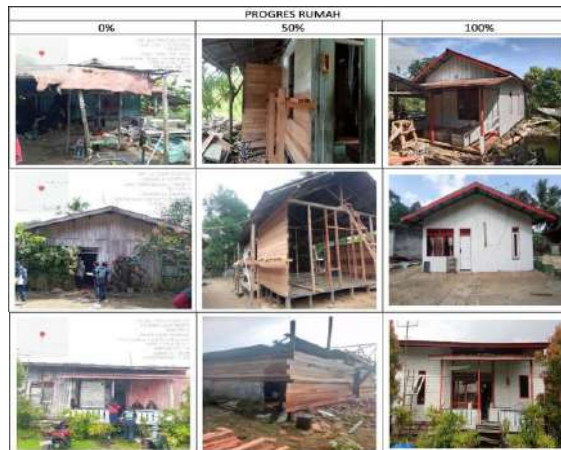
Rehabilitasi Rumah Tidak Layak Huni di Desa Wonotirto Kecamatan Samboja
