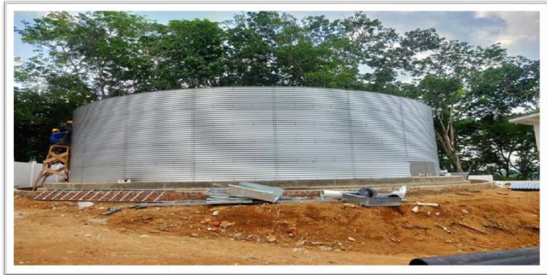
Pembangunan Boster Loa Ipuh Darat dan Jembatan Pipa JDU menuju Boster Kecamatan Tenggarong
