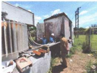
Pemeliharaan Jaringan Listrik Pulau Kumala
